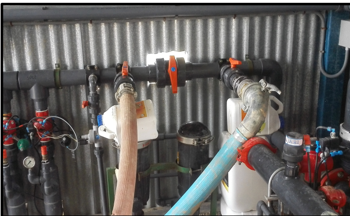
Diferentes conexiones de by pass realizadas para la adecuación de la instalación de riego a la AGRZ800.
